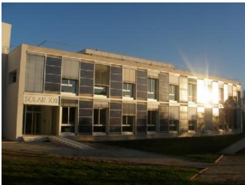
*Figura 5:* Fachada sul do Edifício Solar XXI no INETI, em Lisboa. Inclui sistema fotovoltaico com 76 painéis de silício multicristalino (área total de 96m<sup>2</sup>) que irá produzir, em média, cerca de 12MWh de electricidade por ano. O edifício foi inaugurado em Janeiro de 2006. [Fonte: INETI]
